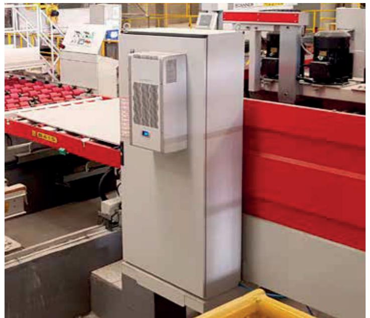
Il quadro elettrico generale è montato sulla parte posteriore della struttura ed è protetto da polvere ed acqua secondo IP 54 (EN 60529).
